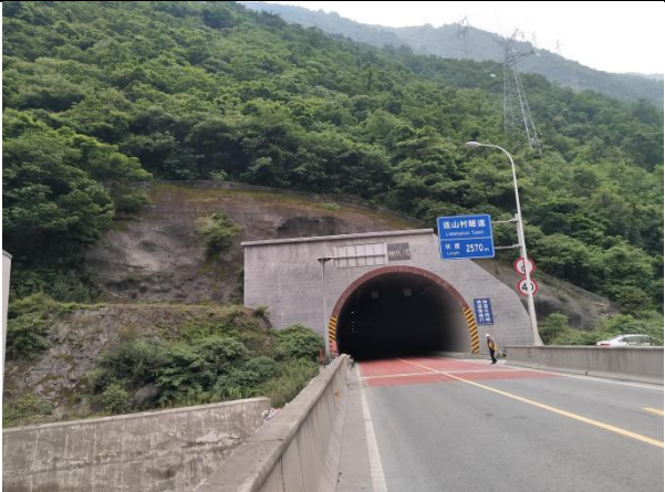
燕子岩隧道现状
