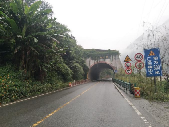
杨家沟明洞现状
