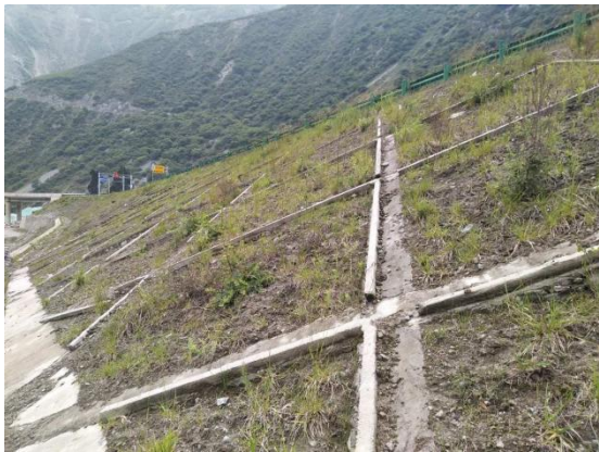
K31+200 填方边坡防护
