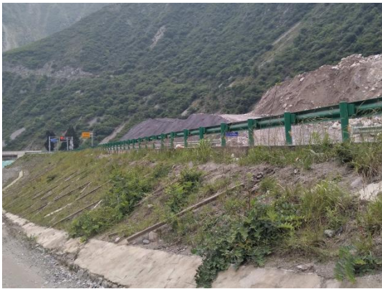
K31+500 填方边坡防护
